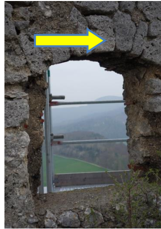
2013: korrekter Tuffstein eingesetzt
